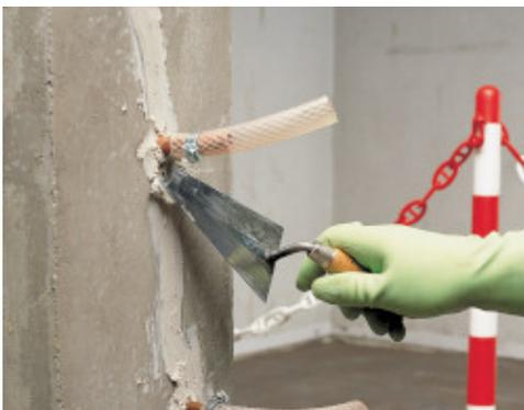
Fixation de tubes d'injection et traitement des fissures lors de la consolidation structurale
