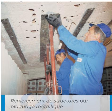
Renforcement de structures par plaquage métallique
